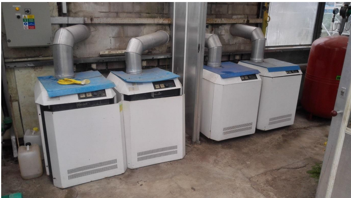
Demontovanie 4ks pôvodných kotlov Protherm 50 PLO a nainštalovanie 2ks stacionárnych plynových kotlov
